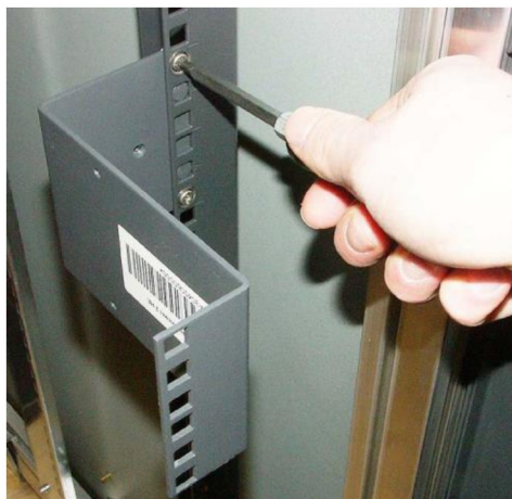
Рисунок 4: Установка опорного кронштейна
